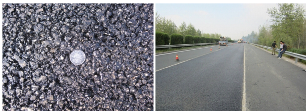
图 3 施工后的再生路面
