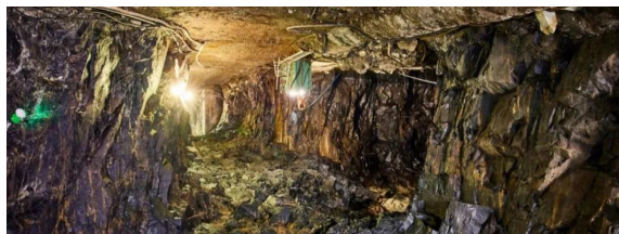
洞穴可存储 30 万立方米的水,保持在 95 摄氏度左右,最大储能容量为 13 吉瓦时
